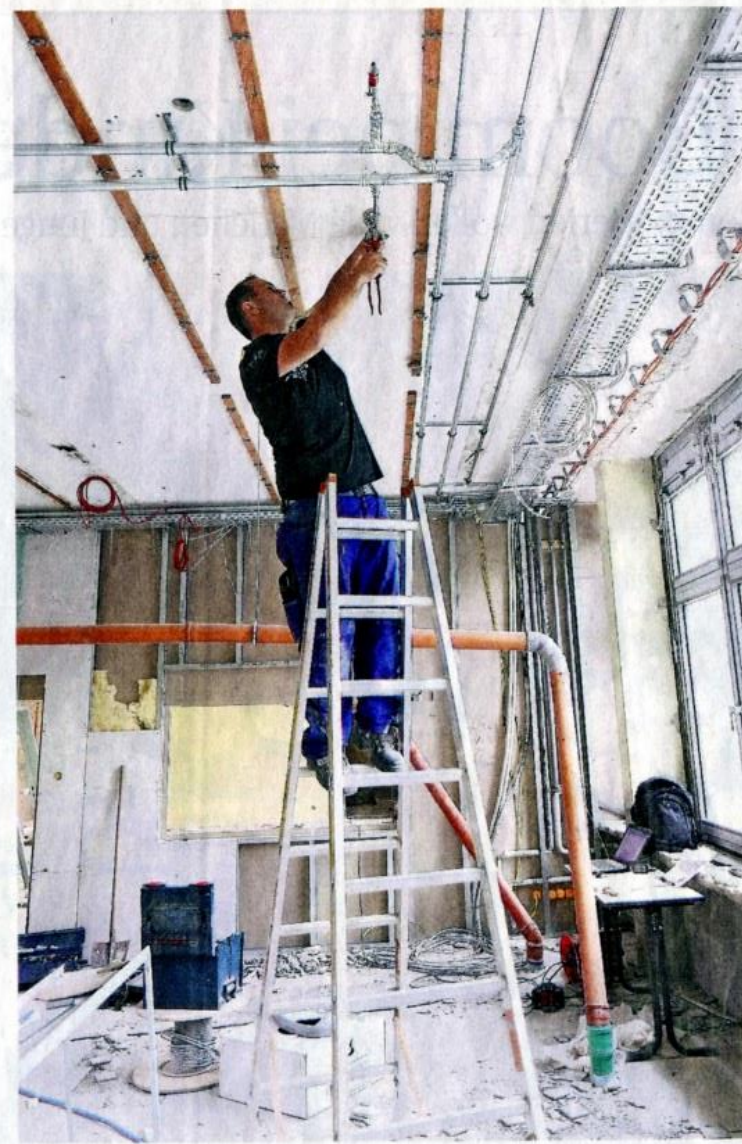
Ein Mitarbeiter der Firma Goldmann aus Thüringen überprüft die Sprengkranlage in der neuen Sekundarschule auf Dichtigkeit. RP-FOTO: OLAF STASCHIK
